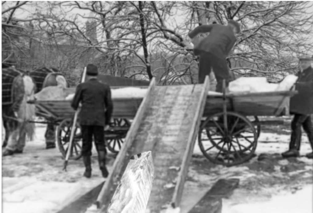
Die Eisblöcke wurden über „Rutschn“ in die Eiskeller eingebracht
