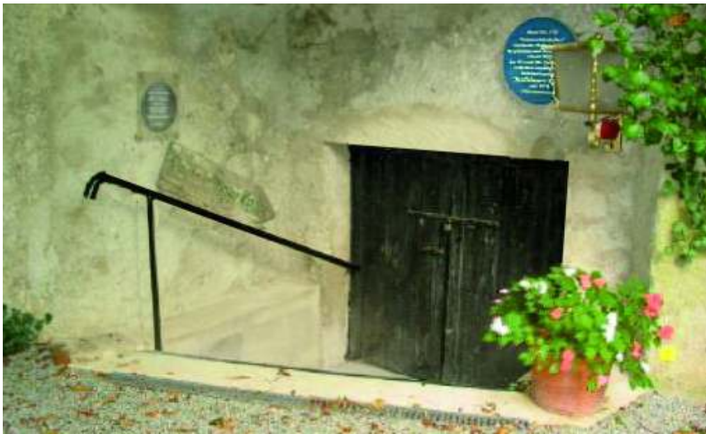
Einziger Zugang zum Unterbau, Eis- und Bierlagerkeller
